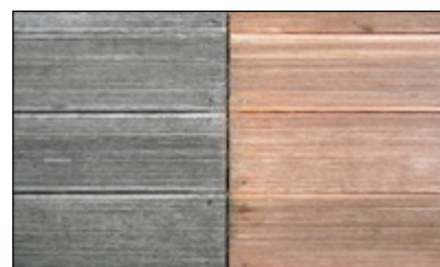
Vor der Reinigung Before cleaning Avant nettoyage Antes de limpiar
