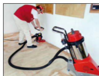
Einfach Randschleifer anschließen für staubarmes Schleifen Connect the edger for low dust emission Branchement à de la bordureuse à l'aspirateur pour une faible émission de poussière Connectar la orillera para una baja emisión de polvo
