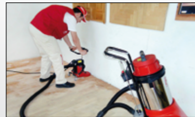
Einfach Randschleifer anschließen für staubarmes Schleifen Connect the edger for low dust emission Branchement à de la bordureuse à l'aspirateur pour une faible émission de poussière Conectar la orillera para una baja emisión de polvo
